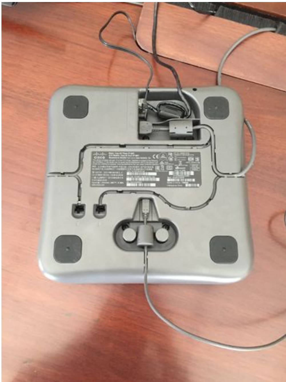
Cableado en el teléfono
