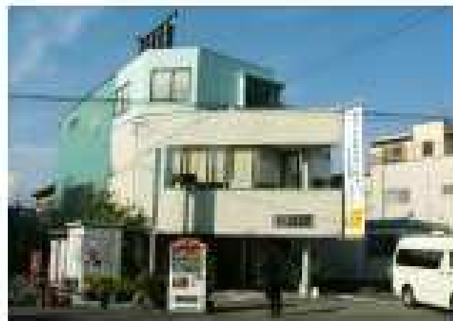
静岡市の応研 本社ビル
