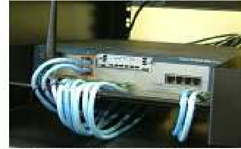
UC500は応研の電話とLANとVPNを司っている。
