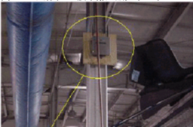
圖17 — 天線在I型波束附近放置不正確
