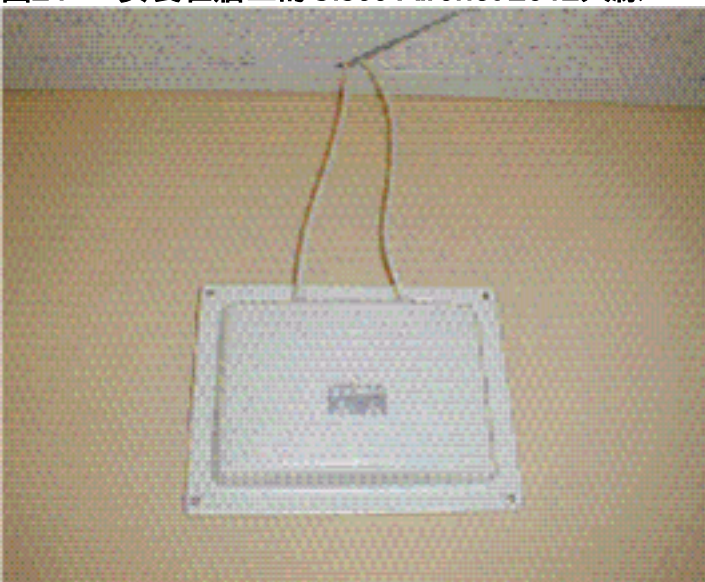
圖24 — 安裝在牆上的Cisco Aironet 2012天線
