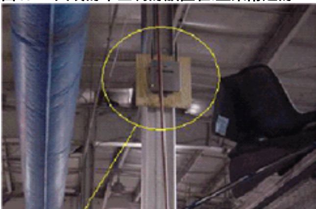
图17 —天线的不正确的放置在I型梁附近的
