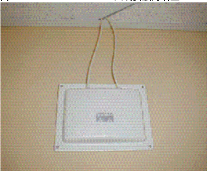
图24 — Cisco Aironet 2012天线安放对墙壁
