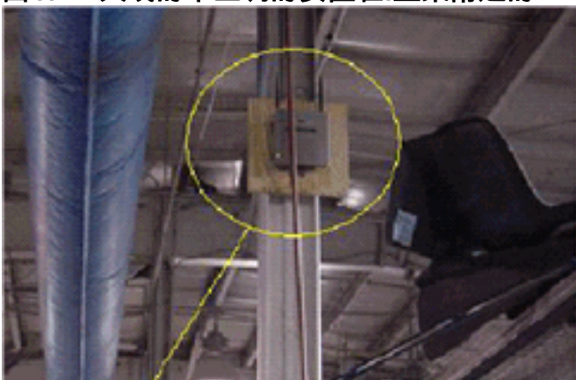
图17 —天线的不正确的安置在I型梁附近的
