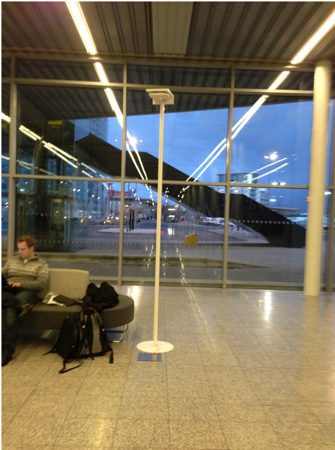
図 38: 必要な場所に AP を配置 : 見た目の良い AP スタンドの例。多くの場合、地域のディスプレイ会社からレンタルできます。
