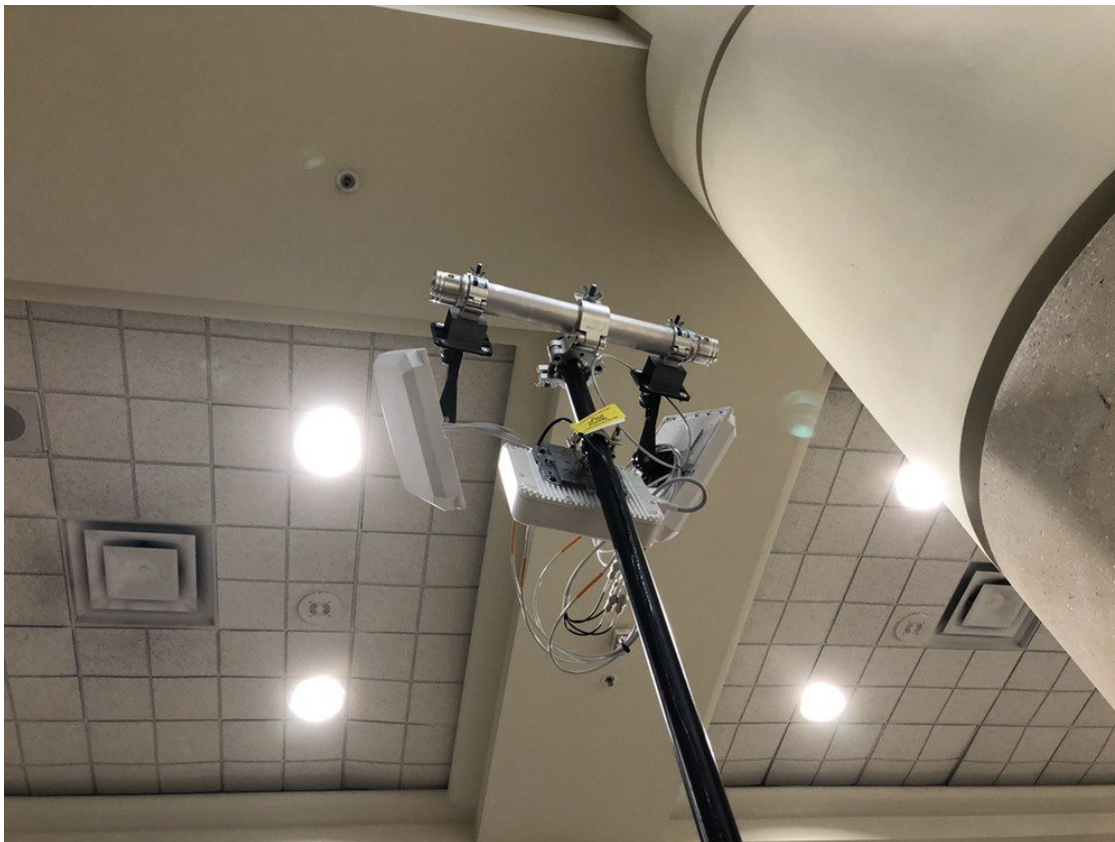
図 40:市販のハードウェアを使用したデュアル 5 GHz の取り付け
