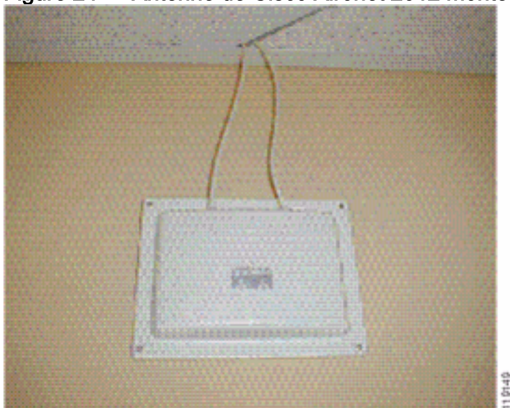
Figure 24 — Antenne de Cisco Aironet 2012 montée à un mur
