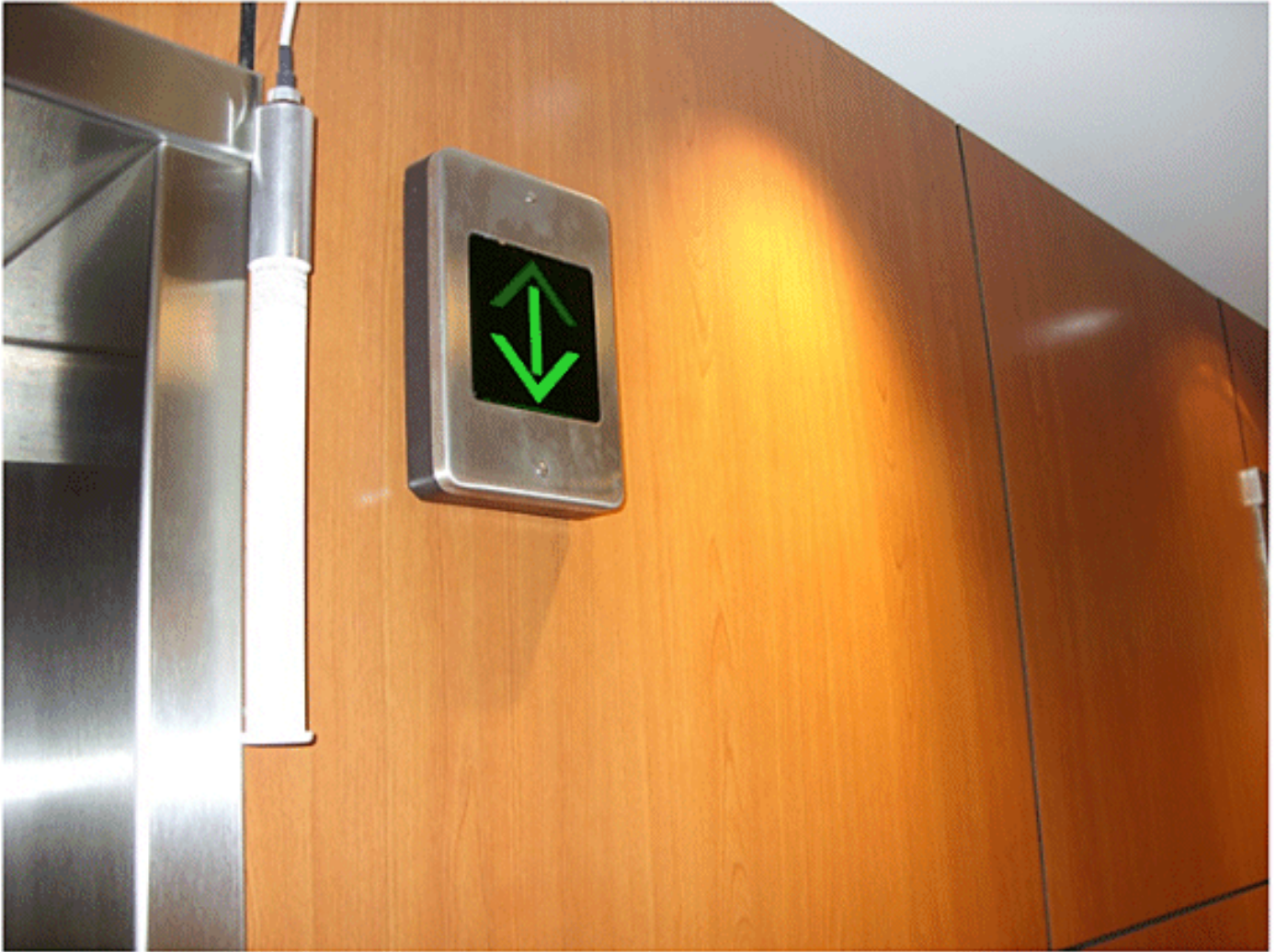
Abbildung 13: Schlechte AP-Positionierung - APs dicht nebeneinander aufgestellt
