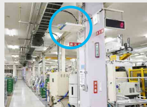
AP や有線 LAN をつなぐ拠点として MS225 などのスイッチが工場内の各所に設置
