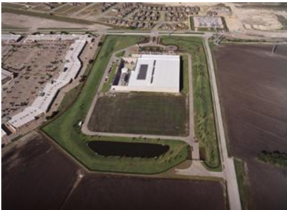
図3 シスコ Allen Data Center の空撮写真
