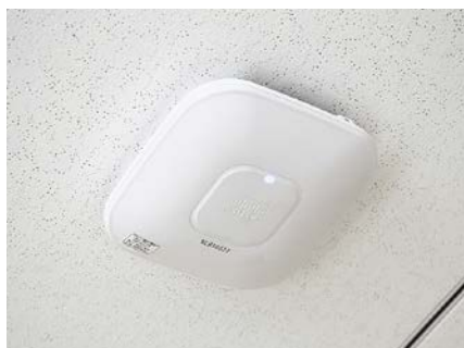
執務フロアに設置されている Cisco アクセス ポイント
