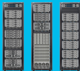
Infrastructure IT classique
