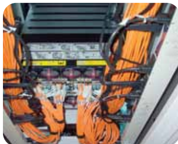
Cableado para un entorno de servidores blade tradicional
