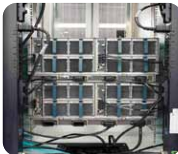
Cableado para un entorno de servidores blade Cisco UCS
