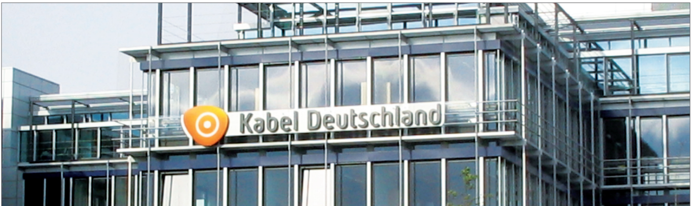
Headquarters Kabel Deutschland Unterföhring
