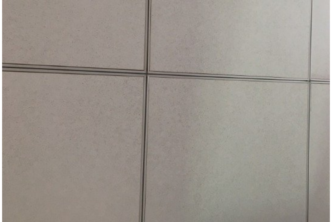
图 14: 细轨（凹式导轨）天花板上使用的导轨示例
