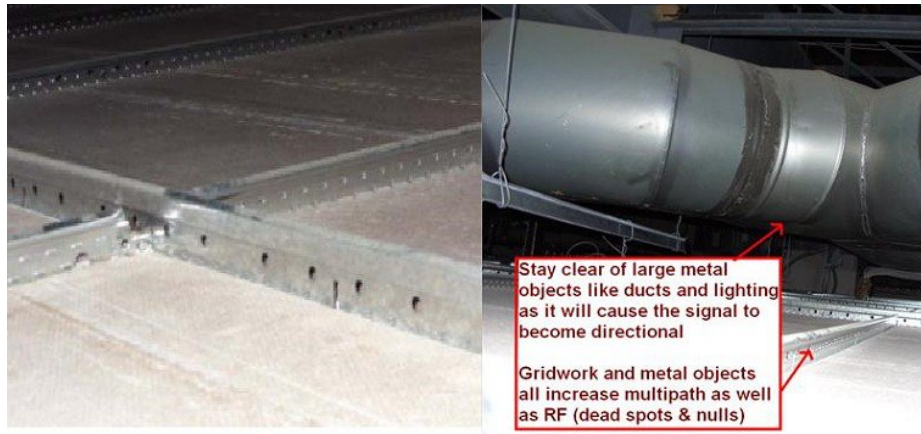
图 26: 在天花板瓦内安装无线接入点：选择无障碍的区域，避免天花板杂乱无绪
