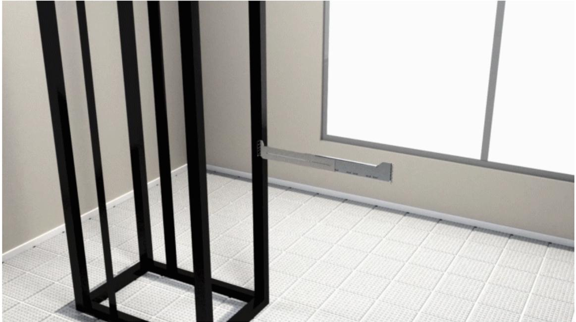
*Figura 35: Inserimento della guida di scorrimento sul rack da 23" a quattro montanti*
