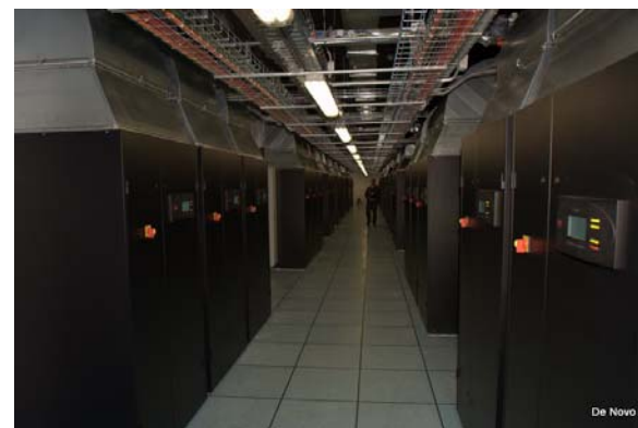
H-модуль (50 стоек, 400 кВт)
