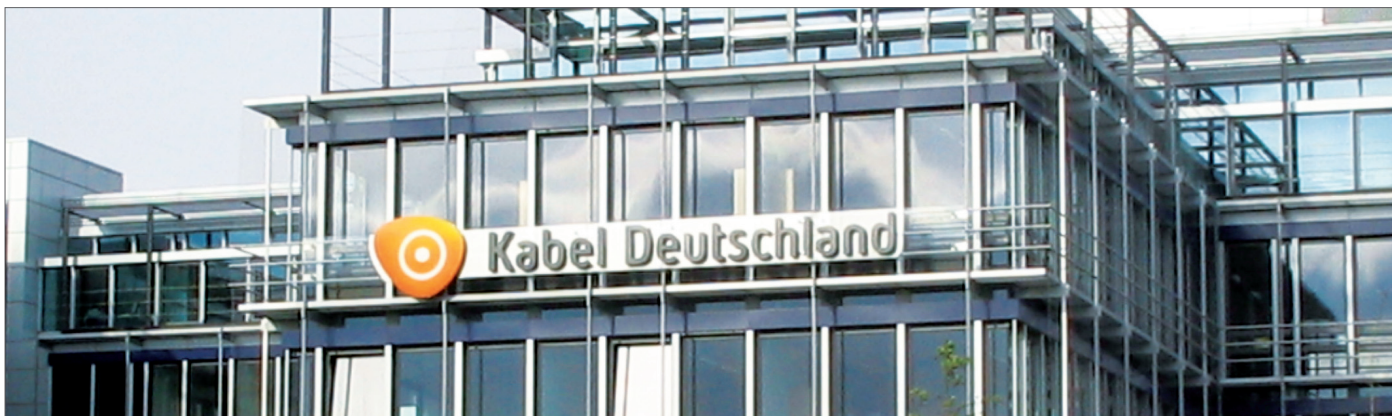
Headquarters Kabel Deutschland Unterföhring
