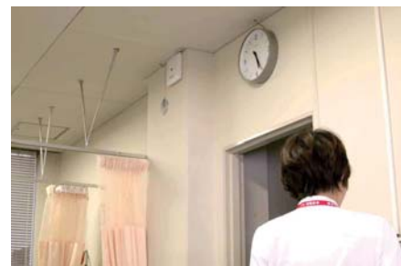
診察室のCisco Aironet 1131。病院内のあらゆる場所から無線LANにアクセスできるよう、合計で約400台のアクセスポイントが設置されている。
