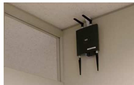
フロア壁面に設置されたCisco Aironet 1240AG。合計で35台導入され、約350台の無線LAN対応PCをネットワークに接続している。
