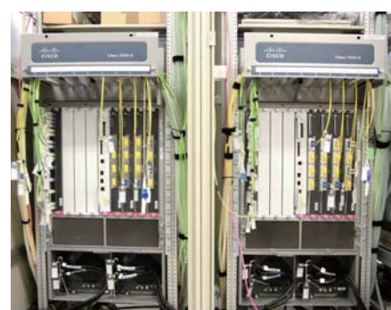
基幹スイッチとして導入されているCisco 7609-S。冗長構成となっており、スイッチ間は10Gbpsで接続されている。
