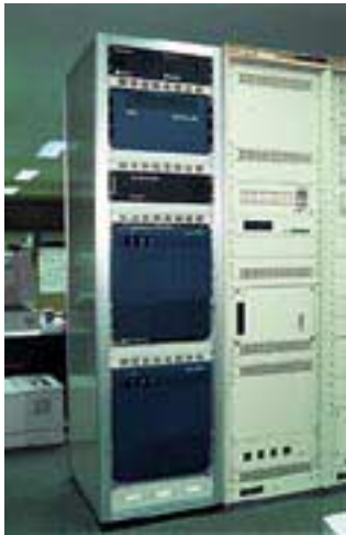
622MbpsのATMによるバックボーンを構成するCisco 7500, LightStream 1010, TeraLink 1000.
