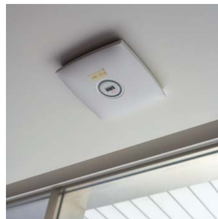
マシンルームに設置されたCisco製品群。（上） 院内の天井に取り付けられたCisco Aironet。（下）
