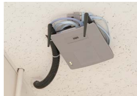
広島大学放射光科学研究センターに設置されたワイヤレスアクセスポイント Cisco Aironetシリーズ
