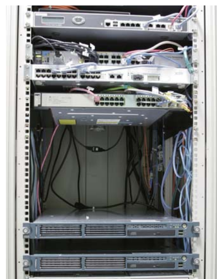
広島大学放射光科学研究センターに設置された Cisco NAC アプライアンス (Clean Access)
