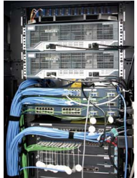
完全二重化された Cisco ISR 3845 と Cisco Catalyst 2950
