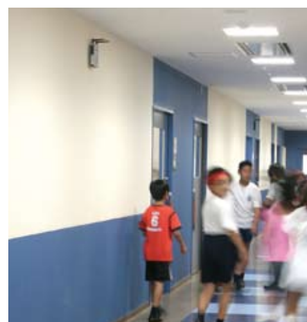
校内廊下の壁面上部にとりつけられたCisco Aironet 1200。
