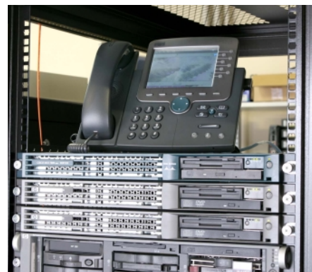
クラスター構成でイクストライド社内に設置されている、Cisco CallManager
