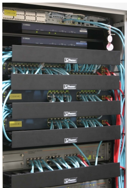
クラスタ構成で導入されているCatalyst3560。
