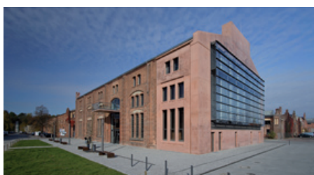
Tradition trifft Technologie: Geschichtsträchtige Backsteinbauten werden in der TFH Wildau mit modernster Infrastruktur kombiniert – so auch in Halle 10, die Bibliothek, Mensa und Cafeteria beherbergt.
