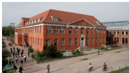
Zentrale Verwaltung: Haus 13 beherbergt Hochschulrechenzentrum, -verwaltung sowie weitere zentrale Einrichtungen, die den hohen Standard der Fachhochschule sichern.
