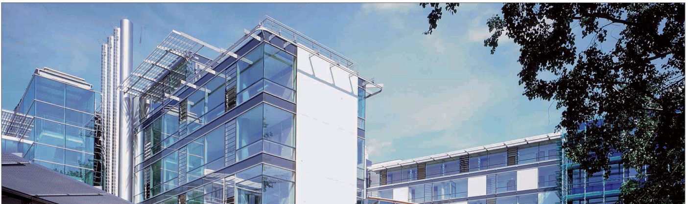
Modern und zukunftsorientiert – Die Hauptverwaltung der DRV Schwaben in der Dieselstraße in Augsburg
