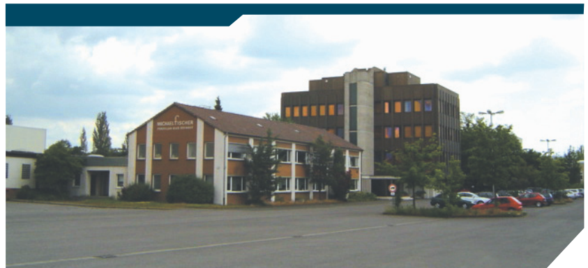
Hauptgebäude Michael Fischer oHG in Bamberg
